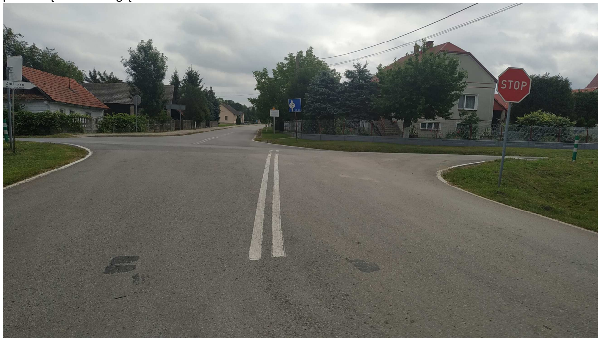
Fot.14 Przesunięcie osi geometrycznych wlotów podporządkowanych DP1305K i 1313K
